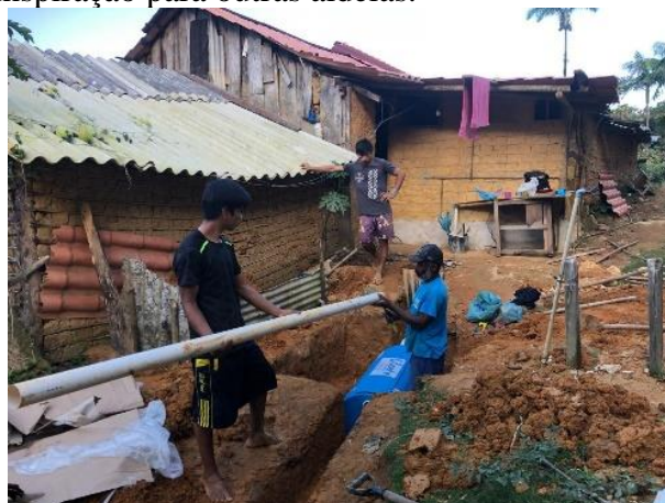
Figura 02: Silvio, Wilson e Gabriel instalando o sistema de tratamento de esgoto (Fonte: OTSS)
